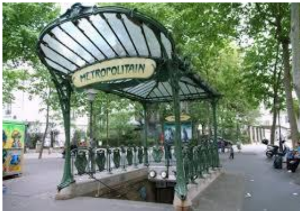
Entrée ou « bouche » de métro typique de l'Art Nouveau, ce style architectural à la mode vers 1900
