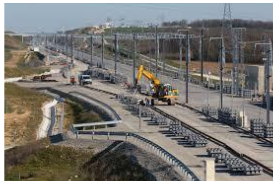
Chantier ligne LGV
